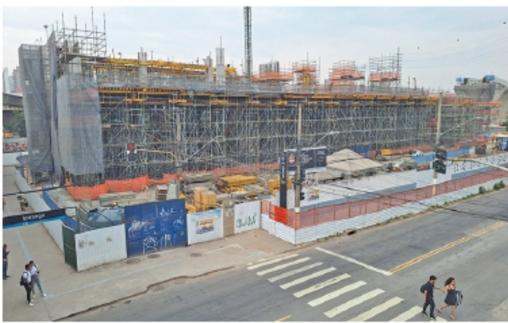
Estação Ipiranga da Linha 15 de monotrilho em obras, já a da CPTM com licitação suspensa
