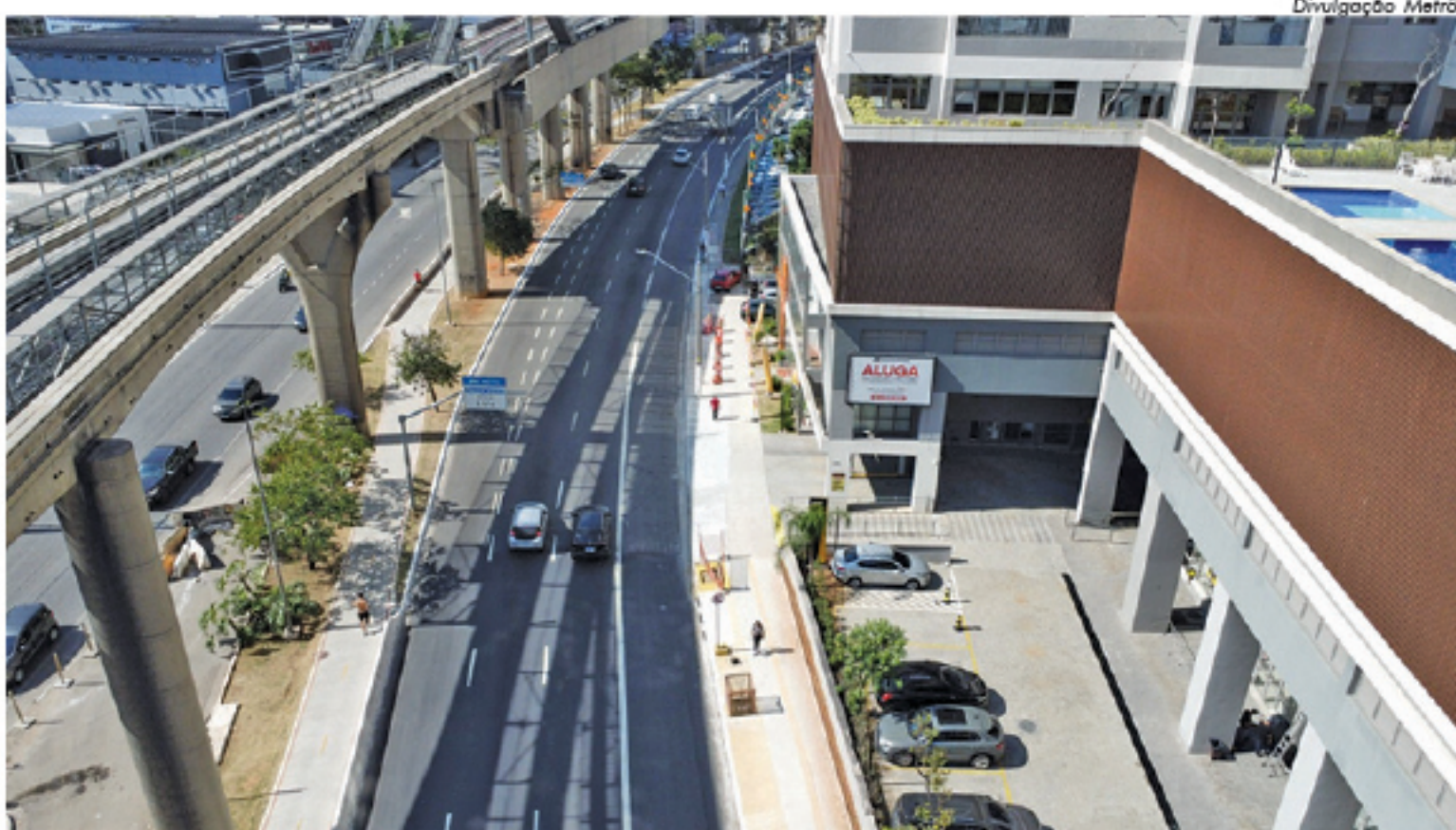
Metrô fez a implantação de cerca de 280 metros de infraestrutura viária
