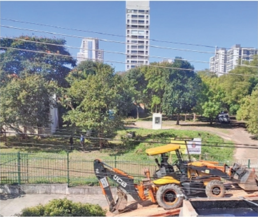
Chegada de maquinário e material nos últimos dias
